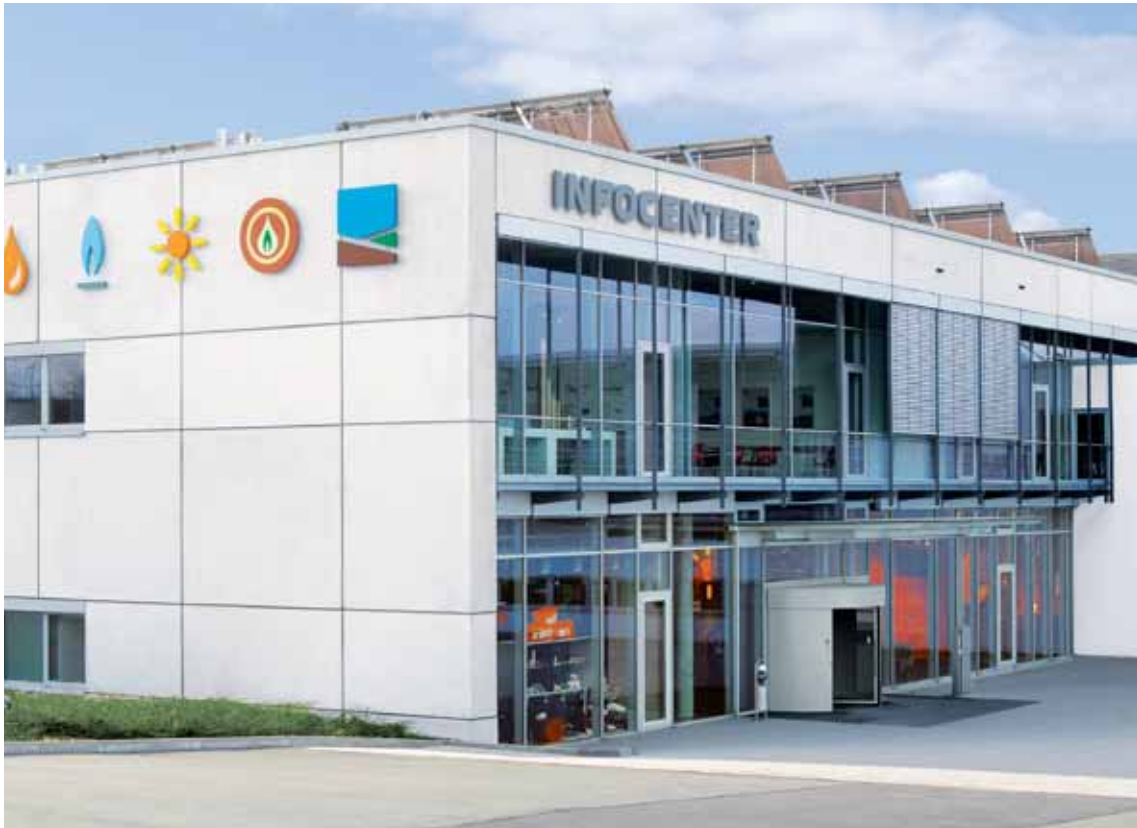
Die Energiezentrale und die Viessmann Akademie in Allendorf
