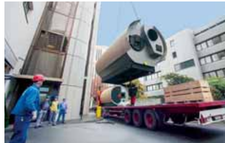
Anlieferung eines Vitomax Kessels auf der Baustelle
