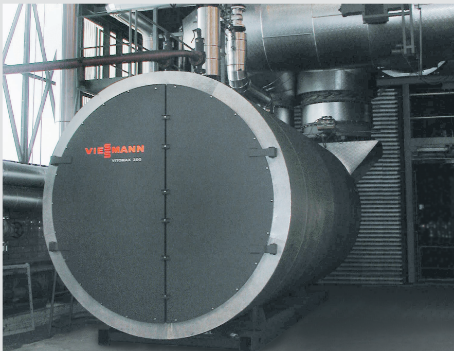
Рис. 8: Двухходовой водогрейный котел-утилизатор
