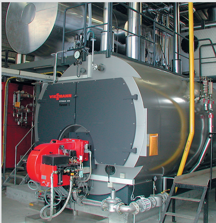
Рис. 2: Паровой котел производительностью 4 т/п в час, 13 бар, с интегрированным пучком дымовых труб для утилизации тепла, рассчитанного на паропроизводительность 0,4т/ч.
