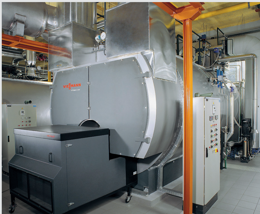
Рис. 14: Паровой котел с функцией утилизации для двух сторонних источников дымовых газов
