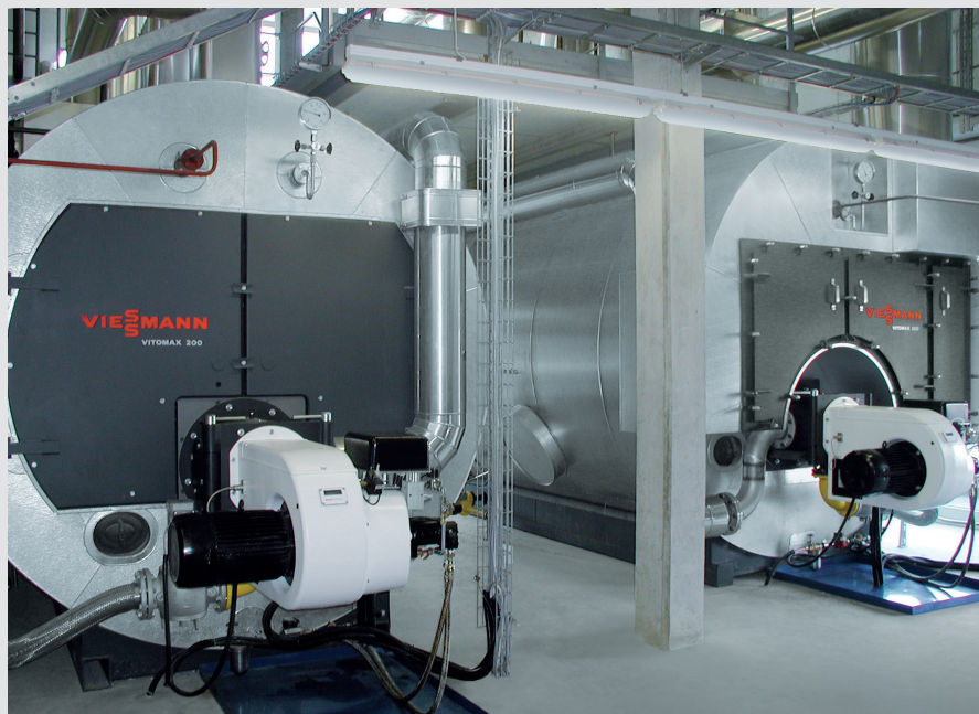
Рис. 16: Паровой котел с утилизатором в комбинации с традиционным паровым котлом
