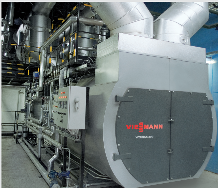
Рис. 10: Паровой утилизационный котел, одноходовой, для двух источников продуктов сгорания
