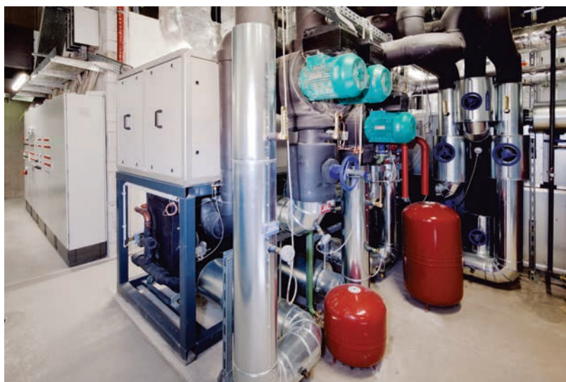
Рассольно-водяной тепловой насос мощностью 286 кВт
